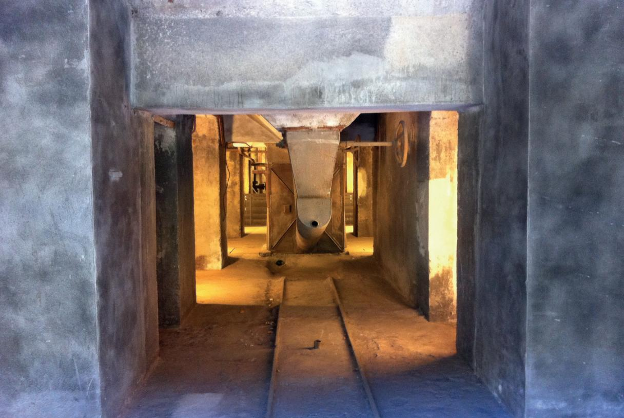
Los raíles indican el lugar donde antiguamente se situaba la **vagoneta**. Posteriormente se modificó este proceso y la escoria y la ceniza caían por el embudo de metal hasta ser arrastradas por el agua hasta el río mediante una canalización que salía de cada caldera.
