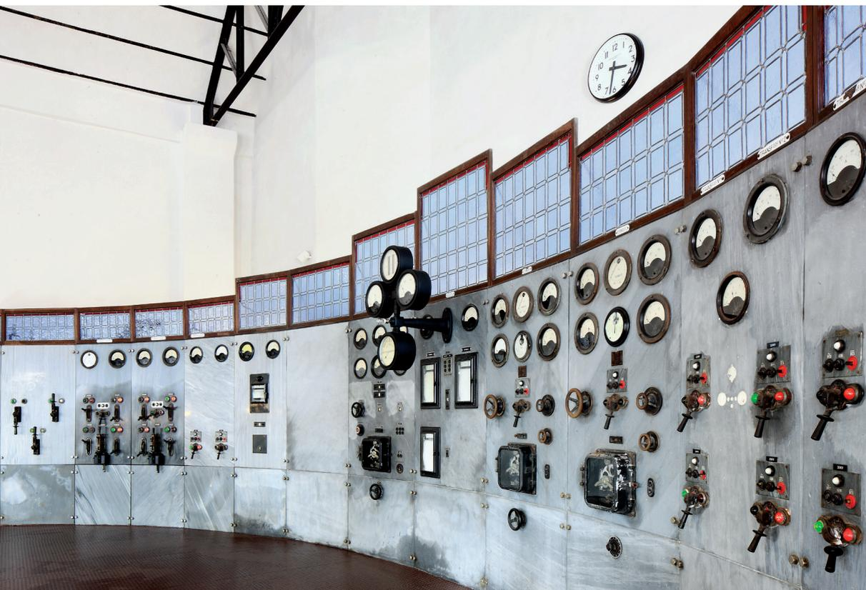
Panel de control de la sala de turbinas. El aparato central que sobresale es el sincronoscopio y gracias a él los operarios acoplaban la corriente eléctrica generada por los tres alternadores, de manera que pudiera sumarse la electricidad producida por cada uno de ellos. La potencia total que podía suministrar la central con las tres turbinas a pleno rendimiento era de 12.600 kW y desde el panel podía enviarse a diferentes destinos.
