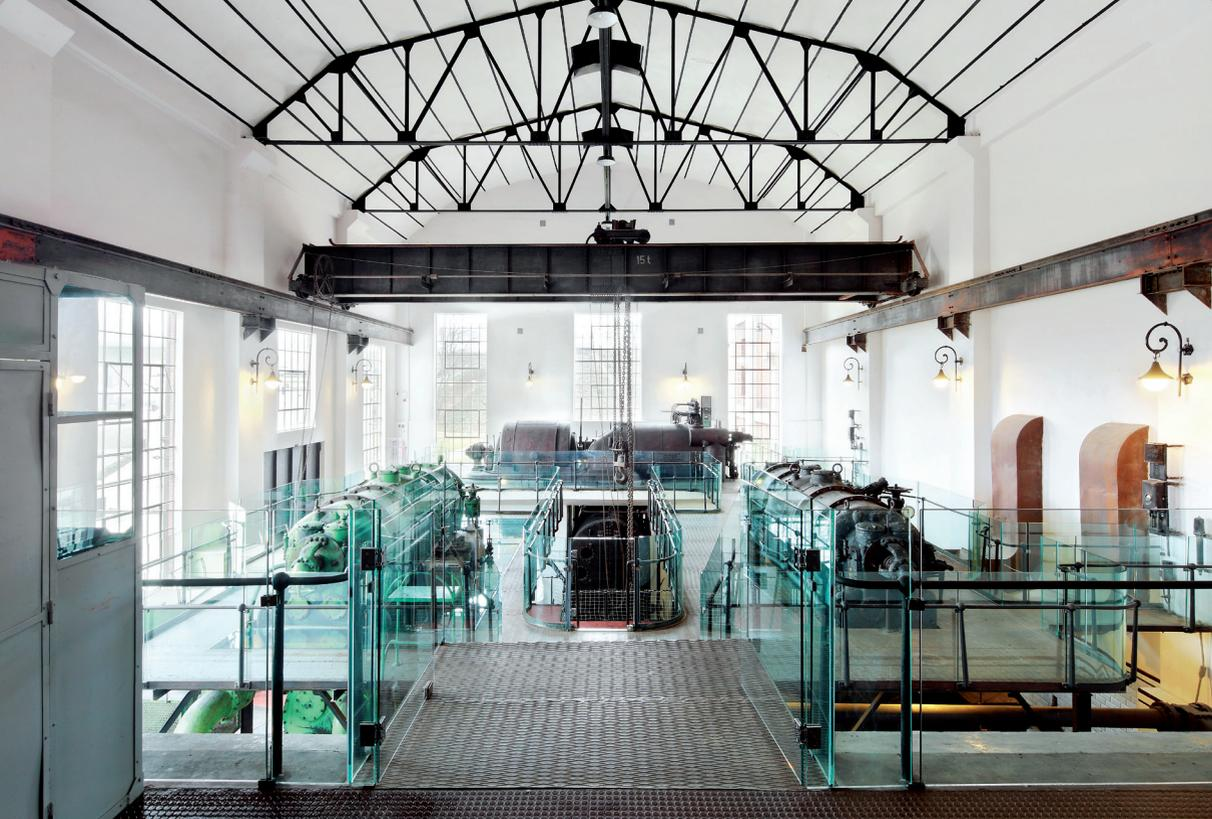
En primer plano las dos turbinas Ljunström y al fondo la turbina Brown Boveri que se instaló en la ampliación de 1946.
